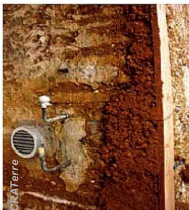
Etape 2 – Application de la technique « terre coulée », à la manière du béton de ciment, à l'aide de banches.
