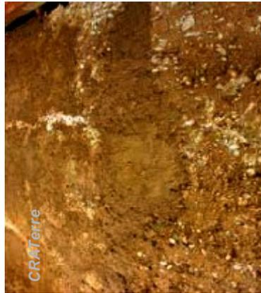
Etape 2 – La fissure a été rebouchée à l'aide d'un mortier de terre
