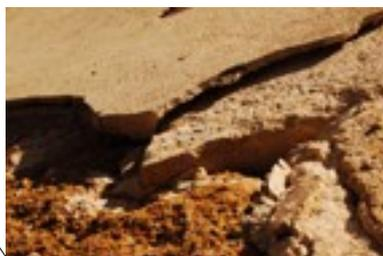
Constat très répandu : **sous l'enduit ciment le pisé n'a pas pu évacuer l'humidité** des remontées capillaires. L'enduit gonfle, se morcelle et le surplus d'humidité a délité la surface du mur.
