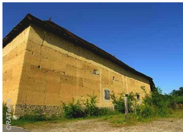
Exemple de bâtiment n'ayant pas été enduit depuis sa construction : le pisé n'a pas subi d'altération due à l'érosion.
