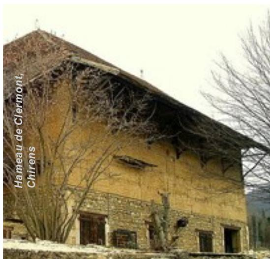
Traditionnellement, les bâtiments en pisé portent de « **bonnes bottes** » et un « **bon chapeau** ». C'est à dire que le soubassement est traité de manière à **éviter les remontées capillaires** (le plus souvent en galets, en pierre ou en briques de terre cuites maçonnées) et le débord de toiture est suffisant pour **éviter le ruissellement de l'eau** sur la façade.
