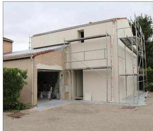
Les travaux d'isolation extérieure ont été le gros chantier. L'ensemble des travaux permettront une économie de 40 % sur la facture d'énergie.
