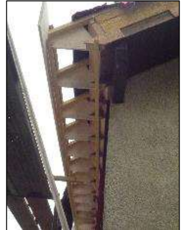
Isolation de la toiture en Sarking
