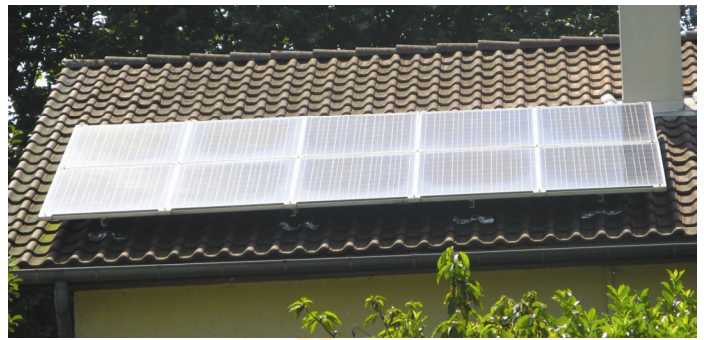
Capteurs solaire photovoltaïque
