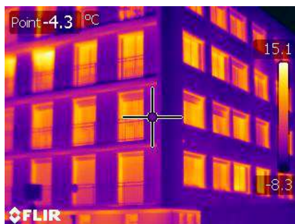
isolation par l'extérieur source ALEC42
