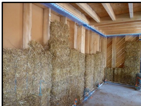
Ossature bois accueillant l'isolation en botte de paille
