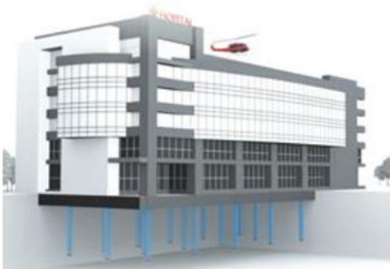
Les fondations géothermiques
