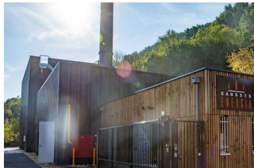
Réseau de chaleur urbain de Saint-Affrique, 5,5 kms de long pour 32 abonnés, 18 GWh livrés et 3,5 MW de puissance bois
