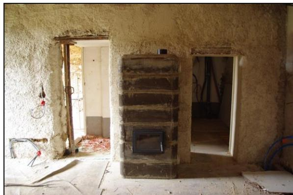
Corps d'enduit chaux chanvre et poêle de masse
