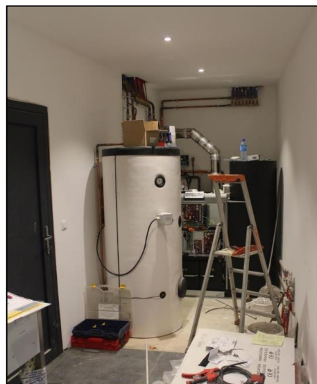
Mise en place de la chaudière à granulé
