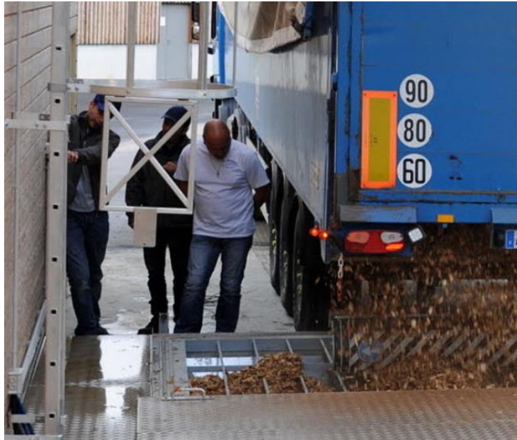
La municipalité a déjà de nombreuses réalisations d'économie à son actif, à l'exemple de cette chaufferie biomasse collective.
