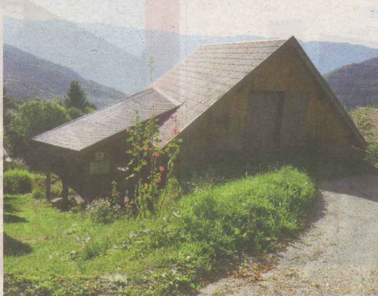
Un système simple permet de réchauffer le niveau semi-enterré.
