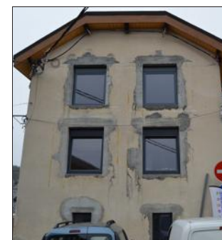
Une façade aveugle a été dotée de plusieurs ouvertures pour bénéficier au maximum du rayonnement solaire.
