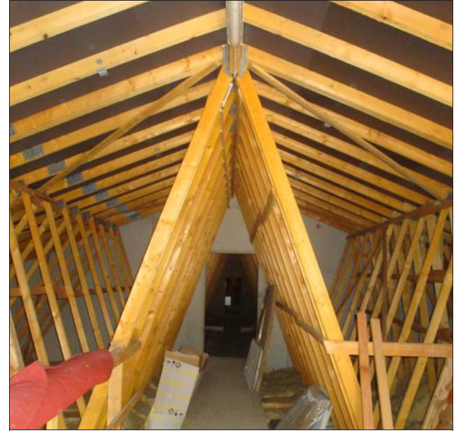
La charpente de l'école devrait notamment accueillir des panneaux solaires.
