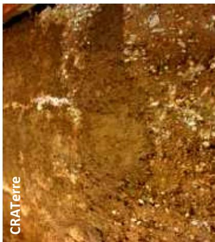
**Étape 2** – La fissure a été rebouchée à l'aide d'un mortier de terre.
