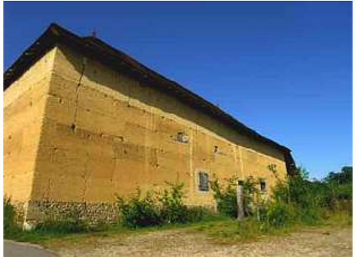
Exemple de bâtiment n'ayant pas été enduit depuis sa construction : le pisé n'a pas subi d'altération due à l'érosion.
