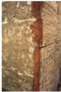
Les **matériaux isolants utilisables doivent être perméables à la vapeur d'eau**, sous risque de provoquer de la condensation à l'intérieur du mur et dégrader la maçonnerie en pisé.
