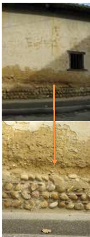
L'humidité est un des points faibles de ce type de bâtiment. Il faut accorder une grande attention aux origines de l'humidité (remontées capillaires, pente de terrain, impossibilité d'évacuation due à une enduit étanche,...). Ce problème complexe peut avoir différentes solutions, dont quelques principes sont à retenir :
