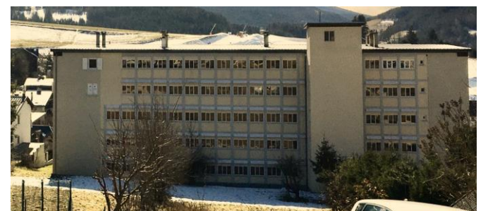
Façade nord avant travaux – coursives très vitrées simple vitrage
