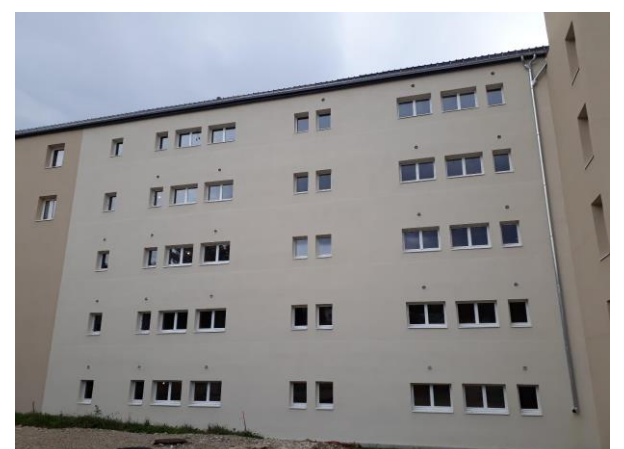
Façade nord après travaux – réduction de la surface vitrée et installation de menuiseries double vitrage
