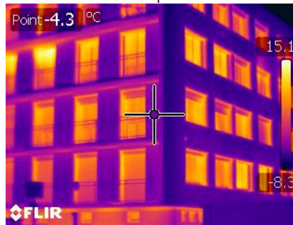
isolation par l'extérieur
