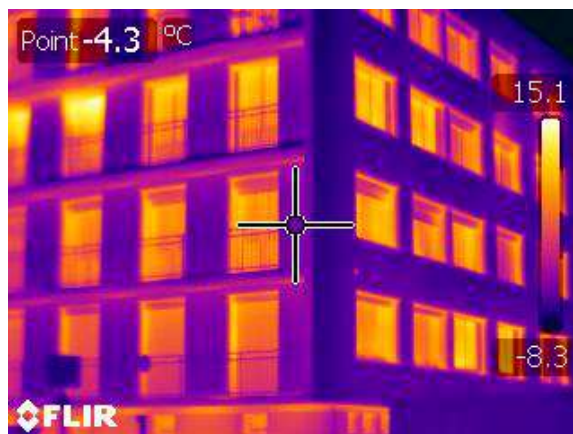
isolation par l'extérieur source ALEC42
