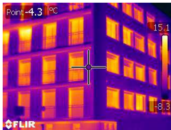
isolation par l'extérieur source ALEC42
