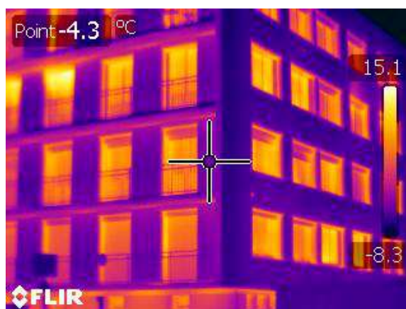
isolation par l'extérieur source ALEC42
