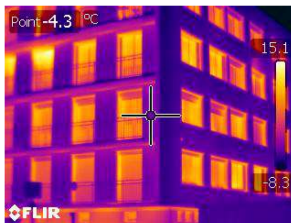
isolation par l'extérieur source ALEC42
