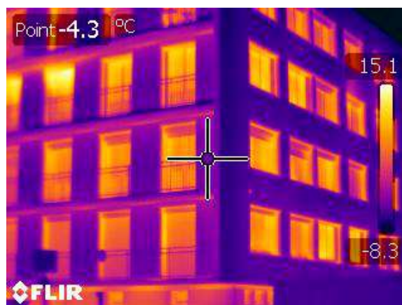
isolation par l'extérieur source ALEC42
