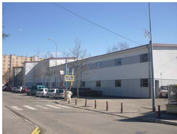
Bâtiment après travaux
