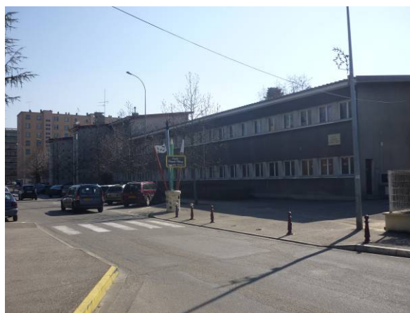
Bâtiment avant travaux
