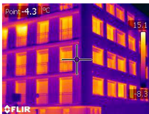
isolation par l'extérieur source ALEC42
