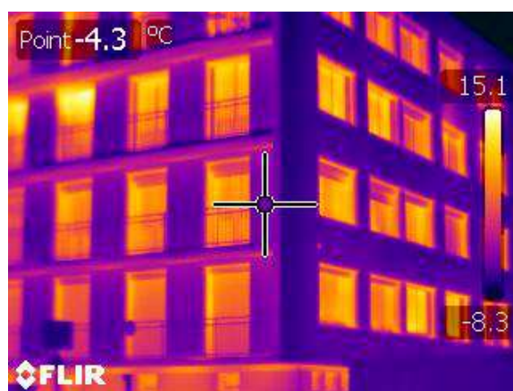
isolation par l'extérieur source ALEC42
